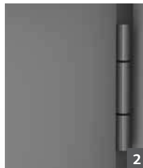
Drei Rollentürbänder in Farbe des Türrahmens
